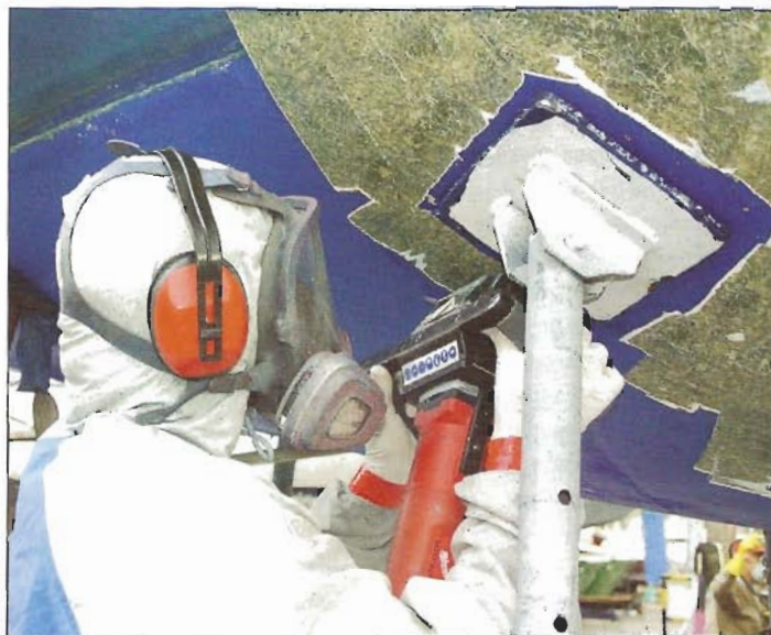
Remoção do gelcoat num tratamento completo de osmose (cortesia Tecniates).
